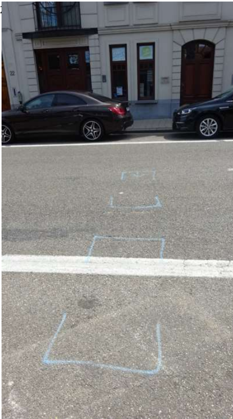
Gelmelstraat 20 – aan rijbaan oneven zijde
